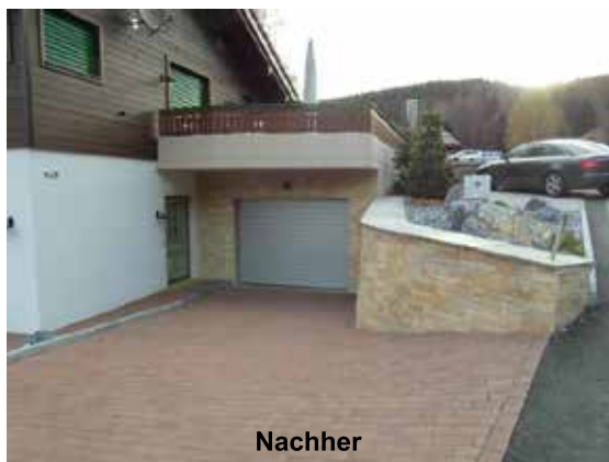
Sichtschutz und Zaunbau
