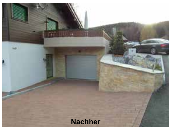
Sichtschutz und Zaunbau
